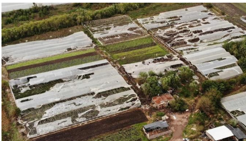
Figura 3: Destrozos de la tormenta del 2017
