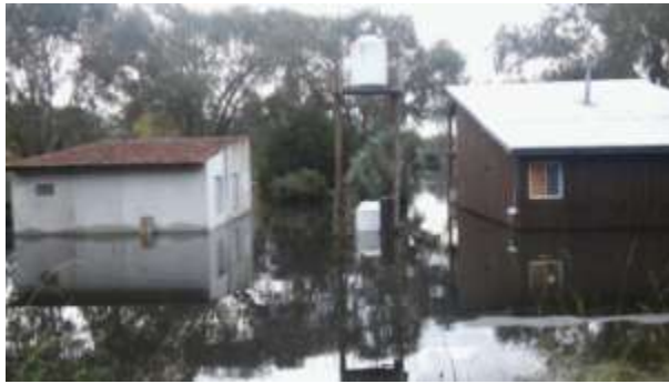
Figura 5. Viviendas sobre albardón costero canal Alem Islas Campana. Crecida (2016).
