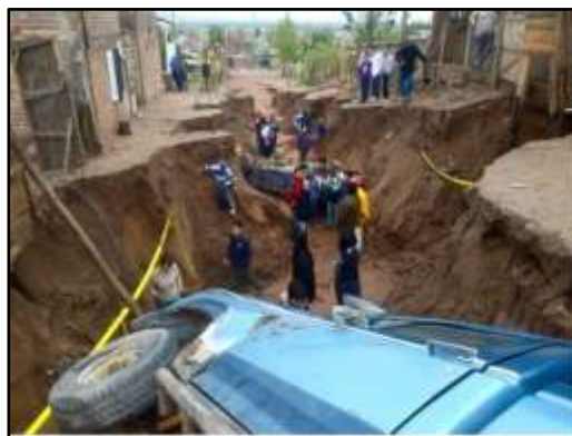
Figura 6: Zanjón producto de la escorrentía superficial encauzada por las calles producto de las precipitaciones intensas del año 2014
