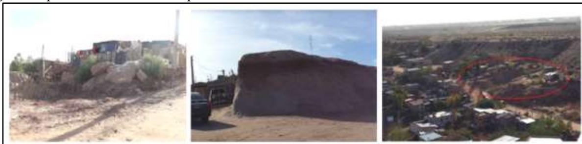
Figura 4: Construcción de viviendas sobre remanentes de erosión y en las laderas de fuertes pendientes disectadas por erosión hídrica
