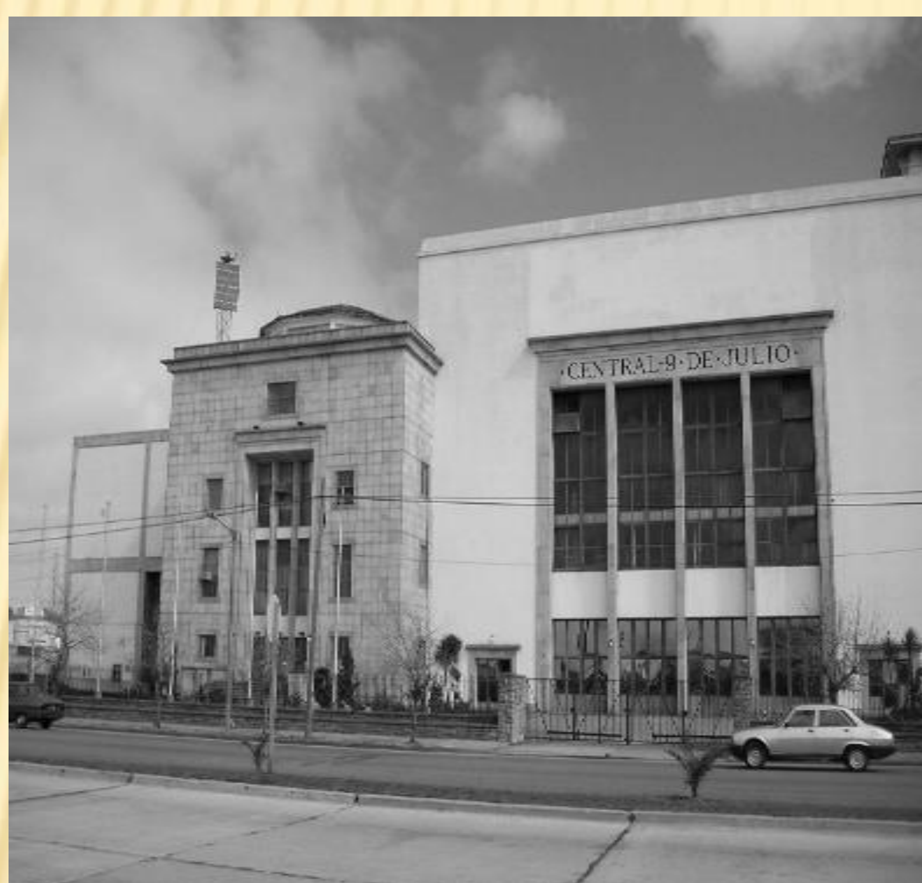
Central eléctrica 9 de Julio. Puerto.
