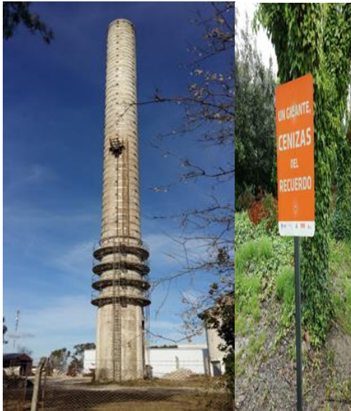
Imagen 8. Chimenea de la fábrica CORCEMAR y señalética del paseo turístico “Un gigante, cenizas del recuerdo”
