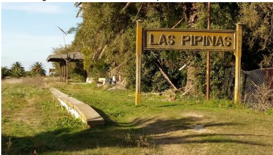
Imagen 2. Estación de tren Las Pipinas en la actualidad.
